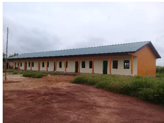
Nouveau bâtiment construit par le PNG
